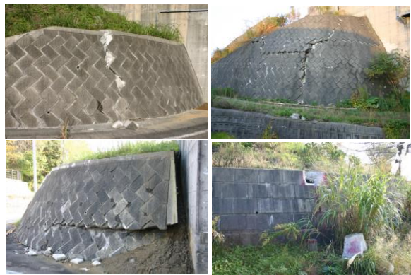
写真 5 関越自動車道のブロック積み擁壁
