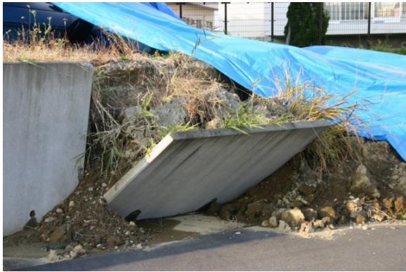
写真 4 小千谷市若葉団地内の宅地の L 型擁壁
