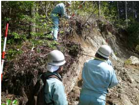
崩壊地頭部の滑落崖の調査
