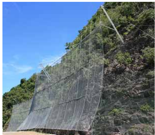
(c)造成地のり面落石対策(須崎市) 写真 5 施工されたロングスパン
