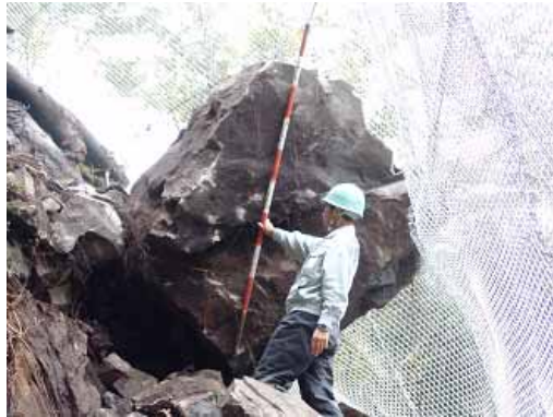
(a)森林基幹道河口落合線工事(香美市物部)
