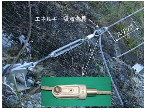
写真1 エネルギー吸収金具
