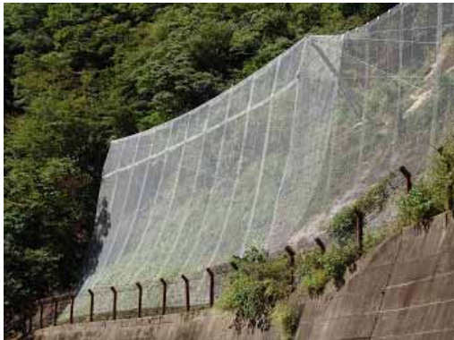
(b) 国道 195 号防災工事 (香美市物部)
